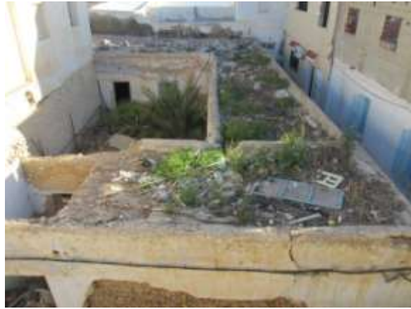
حالة أسطح المعلم قبل الترميم
