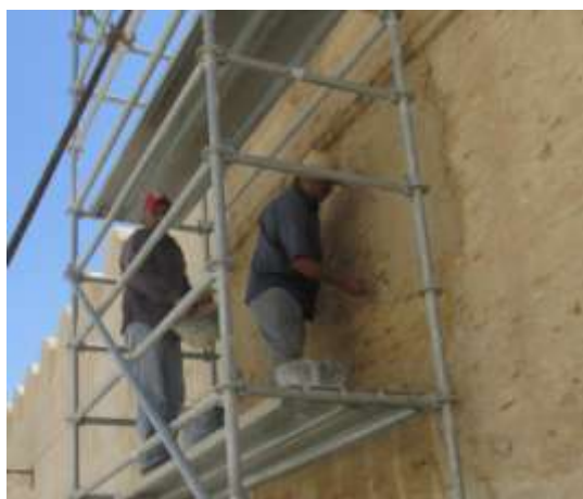
ترميم التصدعات وتغيير الأجر المتآكل
