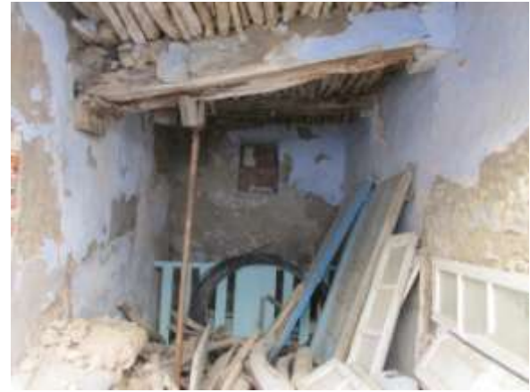
انهيار الأسقف الخشبية ودعاماتها
