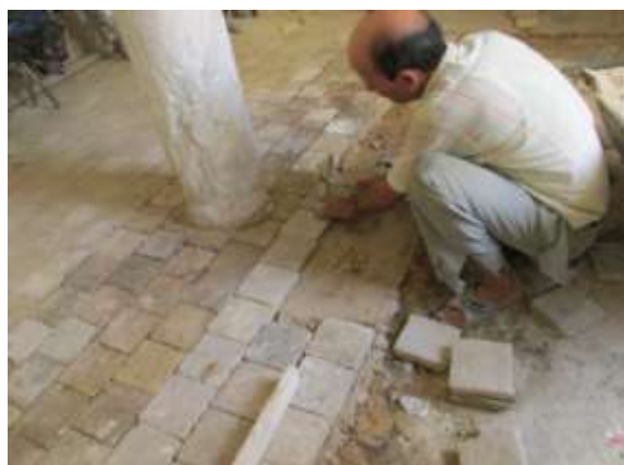
تبليط بيت الصلاة باستعمال مربعات تقليدية الصنع
