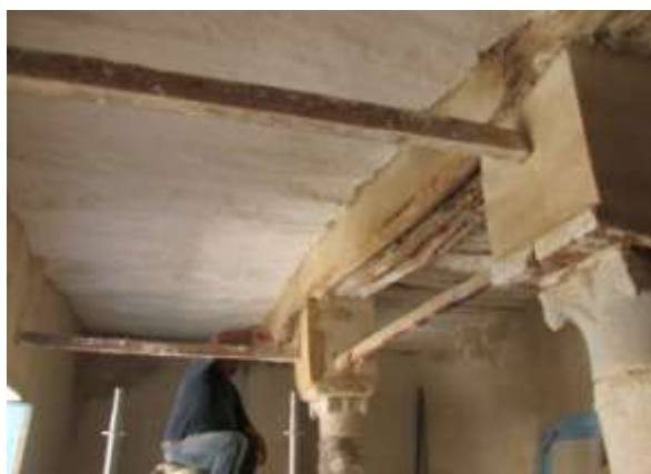
طلاء أعمدة عرعار السقف بالجبس لحمايتها من التسوس
