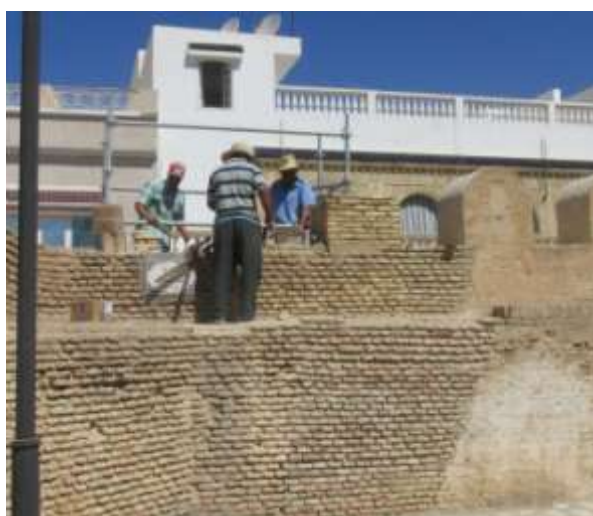
إعادة بناء شرفات السور على الطريقة التقليدية
