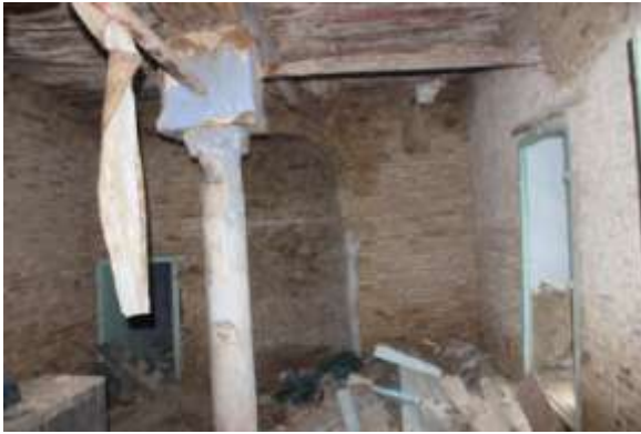
بيت الصلاة قبل أشغال الترميم
