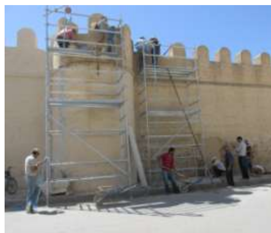
ترميم التصدعات وتغيير الأجر المتآكل
